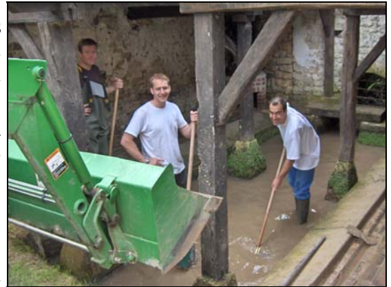
Curage et nettoyage du lavoir
